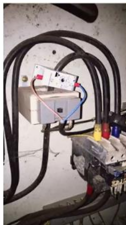
เซนเซอร์วัดค่ากระแสของเครื่องกวนและเครื่องหีบ
