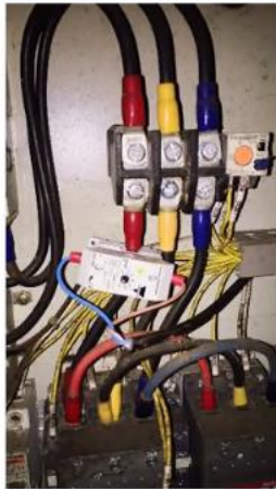
เซนเซอร์วัดค่ากระแสของเครื่องกวนและเครื่องหีบ
