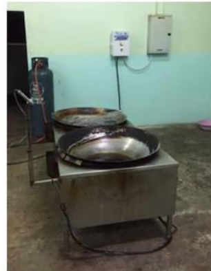
ภาพรวมการติดตั้งระบบ
