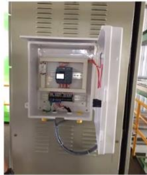
ชุดรับข้อมูล จำนวนการเดินเครื่องของ Screw Press เพื่อส่งสัญญาณไปปรับความถี่ ของกระแสไฟ (Hz) ที่ Inverter โดยอัตโนมัติ
