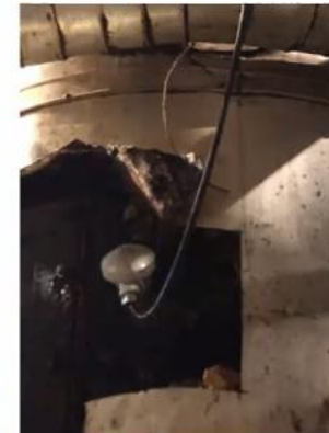
เซนเซอร์วัดค่าอุณหภูมิของเครื่องกวน
