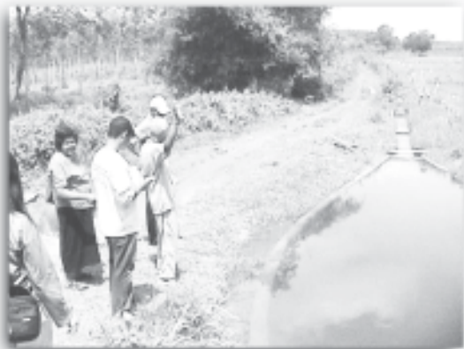
● ระบบชลประทานเหมืองคอนกรีต
