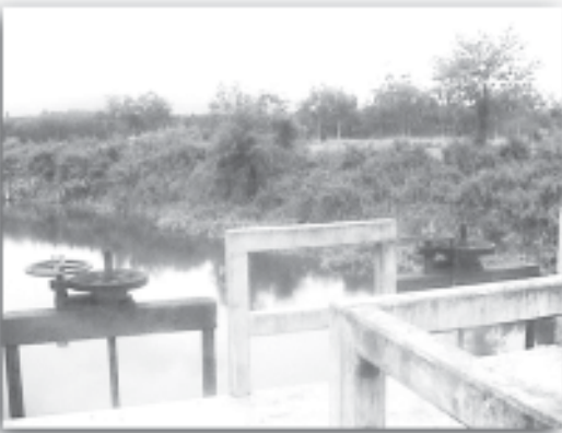
● ทำนบน้ำ-ที่ประตุนบายน้ำสร้างด้วยคอนกรีต
