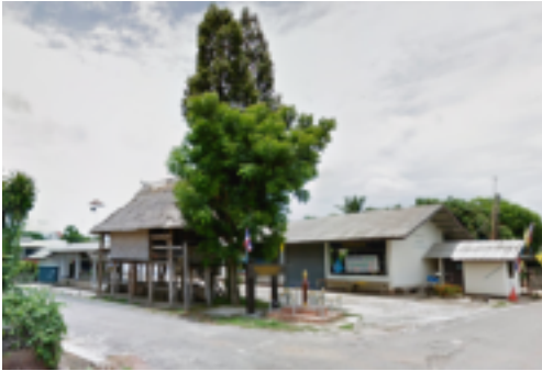
พื้นที่ก่อนปรับปรุง
